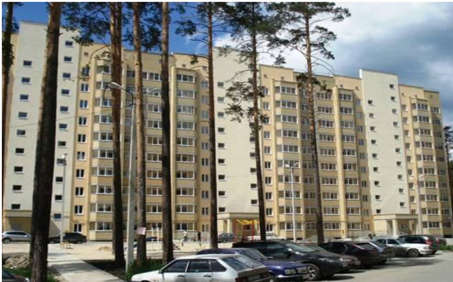
10-ти этажный жилой дом
