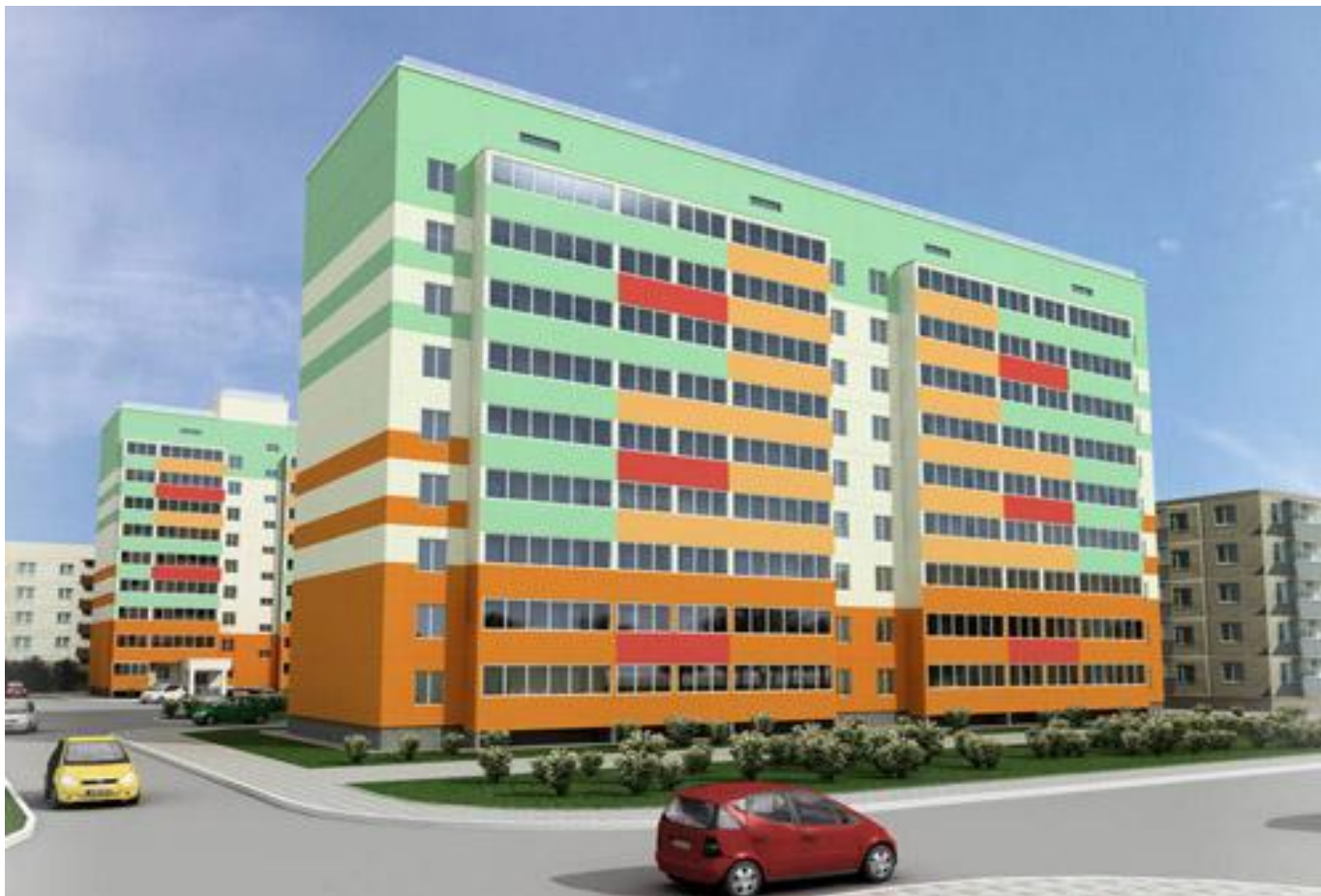
Жилой 9-ти этажный дом Свердловская обл., г. Сысерть, микрорайон Новый, 24 корп.2.
