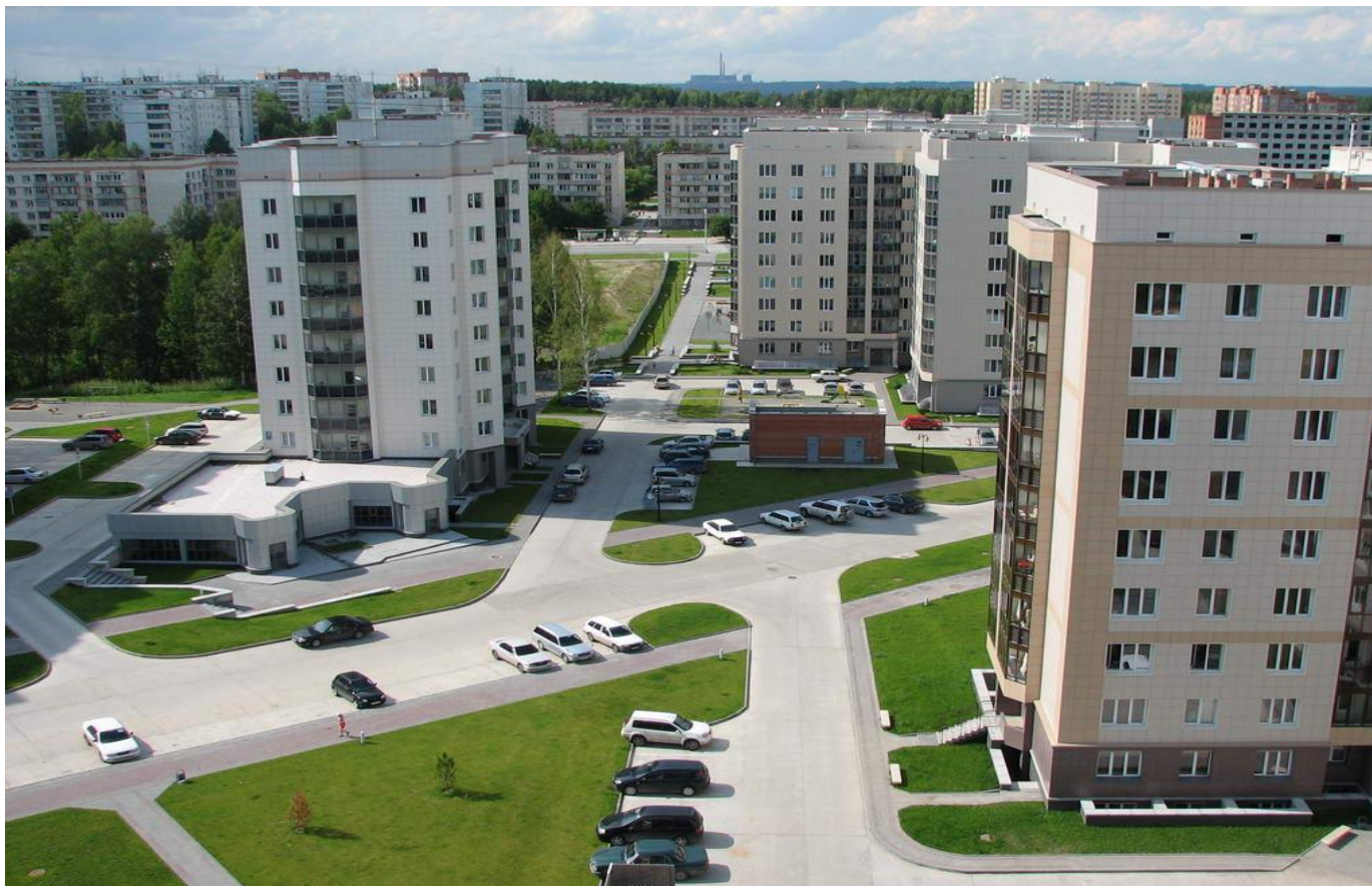
Жилой микрорайон Новосибирская обл., пос. Кольцово
